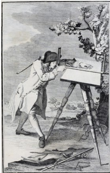
Il. 13. Pomiary wykonywane za pomocą goniografu (źródło: Giovanni-go Jacopo de Marinioni: De Re Ich-nographica : Cujus Hodierna Praxis Exponitur, Et Propriis Exemplis Plu-ribus Illustratur. In Que Varias, Quae Contingere Possunt, Ejusdem Aberra-tiones, Posito Quoque Calculo , 1751, s. 11) 20
